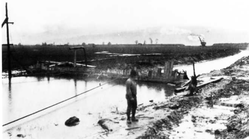
Arbetet med invallningen av Dragsängarna var ett jättejobb även mätt med dagens mått. På den här bilden syns det att det vid den tiden inte fanns särskilt många träd på området. Lägg märke till slängskopan längs bort t h på bilden
