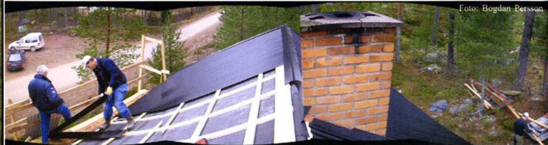
Gryssenstugan får ett nytt tak. Staffan och Lasse lägger plåten, medan Göte langar material...
