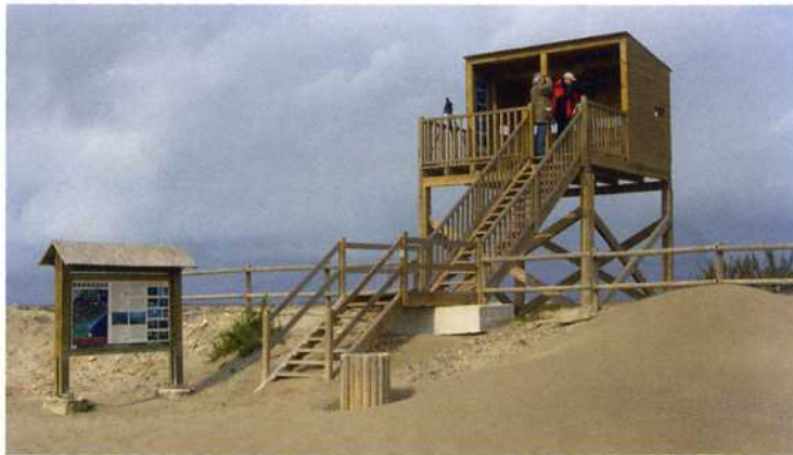
Nybyggt fågeltorn i Ebrosdelta
